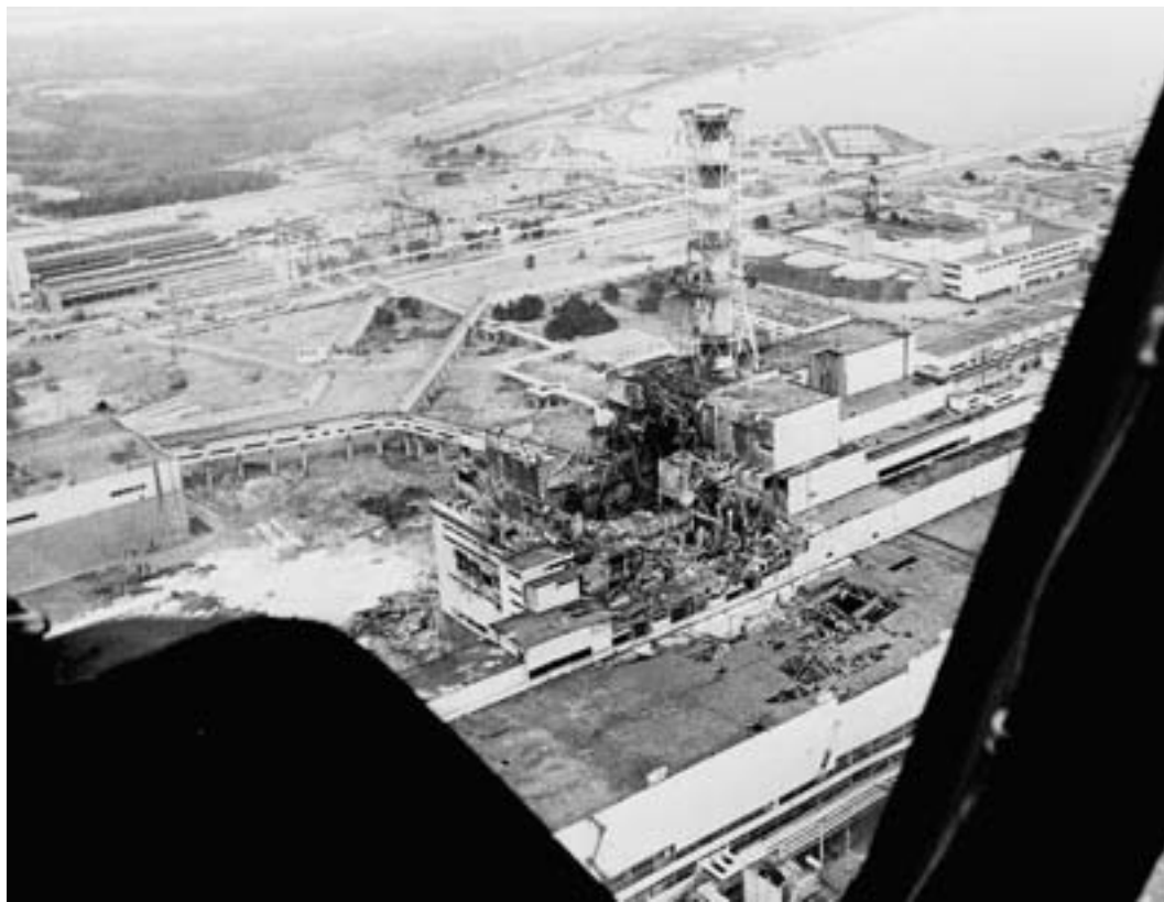
1986. Tschernobyl, Ukraine. Beim sicherheitstechnischen Versuch, einen Stromausfall zu simulieren, geriet der Reaktor ausser Kontrolle. Explosionen verteilten die Radioaktivität über Europa. Foto Keystone
