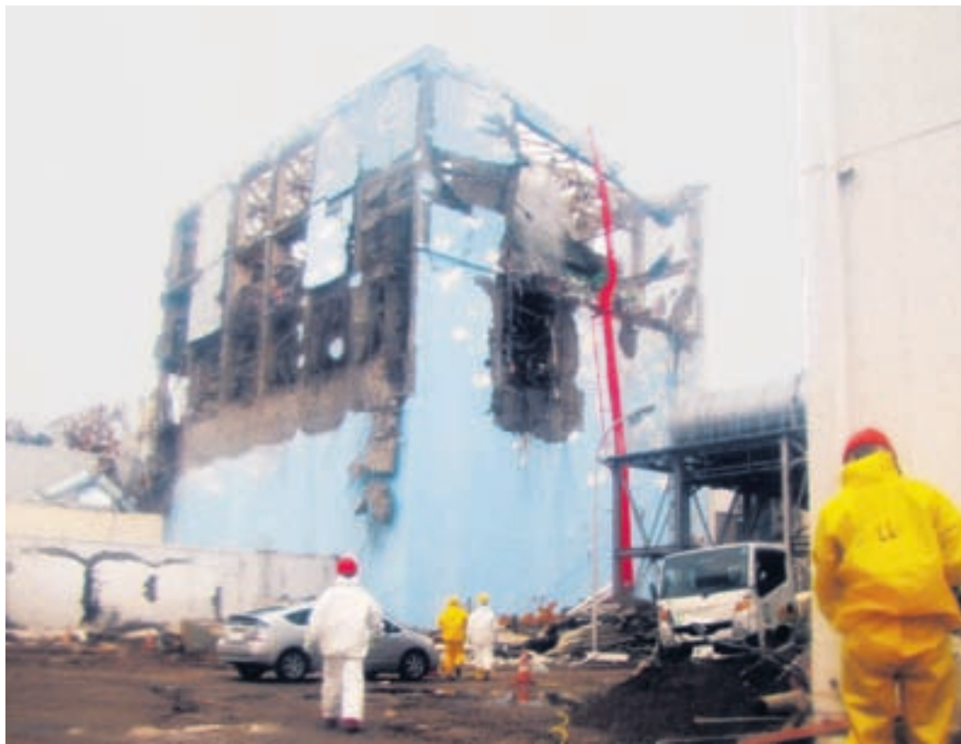
2011. Fukushima Daiichi, Japan. Nach Erdbeben und Flutwelle fielen die Kühlsysteme aus. Es gab Kernschmelzen in den Reaktorblöcken 1 bis 3 sowie Wasserstoffexplosionen (Bild: Block 4). Foto Keystone
